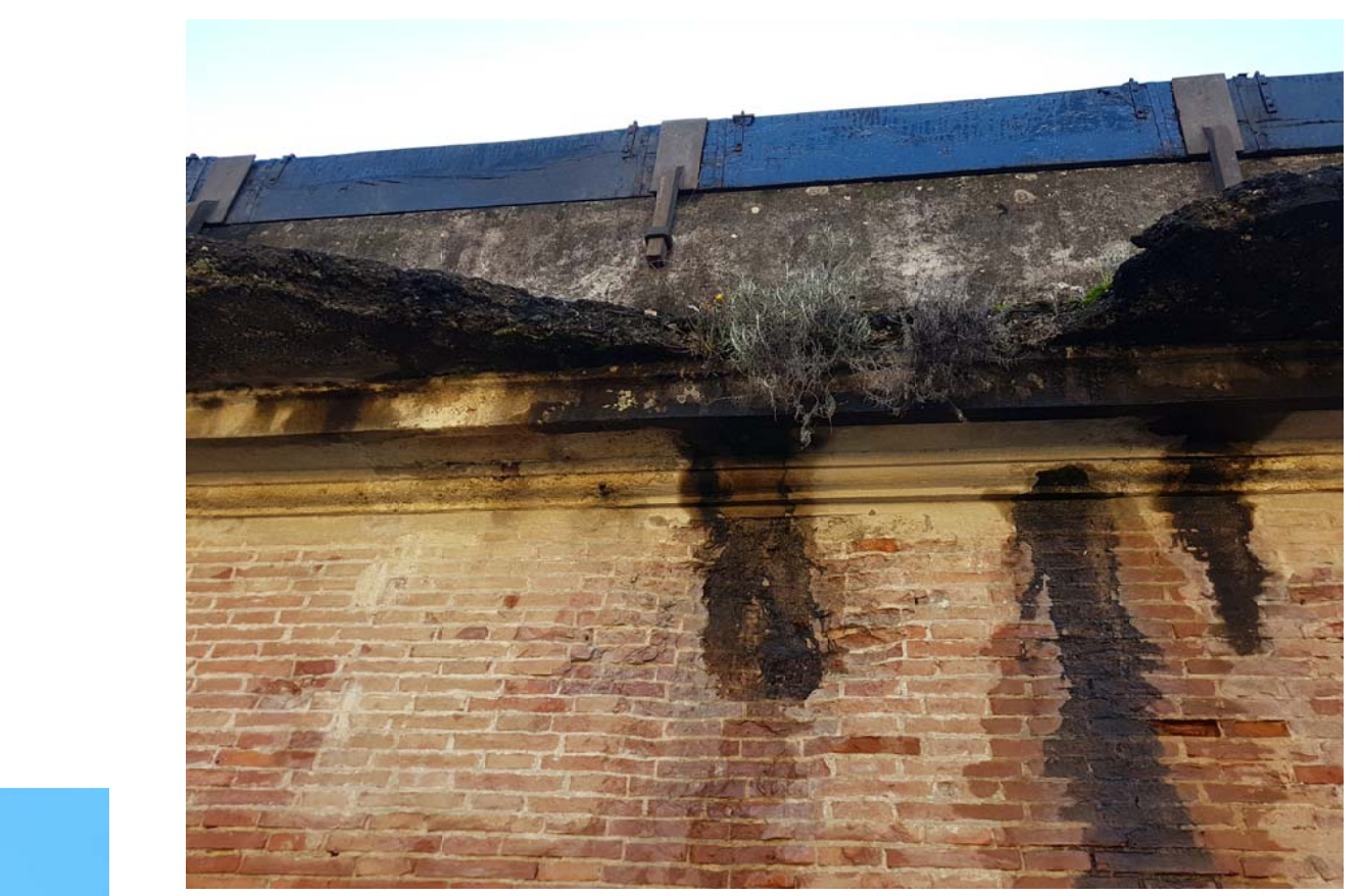
ALTRO ESEMPIO DI DETERIORAMENTO DELLA SOLETTA. PER QUESTE PORZIONI SI E' PREVISTA LA DEMOLIZIONE E RICOSTRUZIONE IN PROFILI DI ACCIAIO A SBALZO, RIVESTITI CON CEMENTO POZZOLANICO E RIFINITURA DEL TUTTO SIMILE ALL'ESISTENTE.
